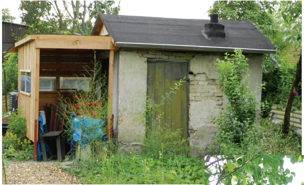
Dach dicht und Schuppen neu, die Rekonstruktion geht voran.
