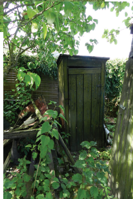
Das Herzhäuschen war nicht mehr zu retten. Stattdessen wird eine Trockentoilette die Dienste übernehmen
